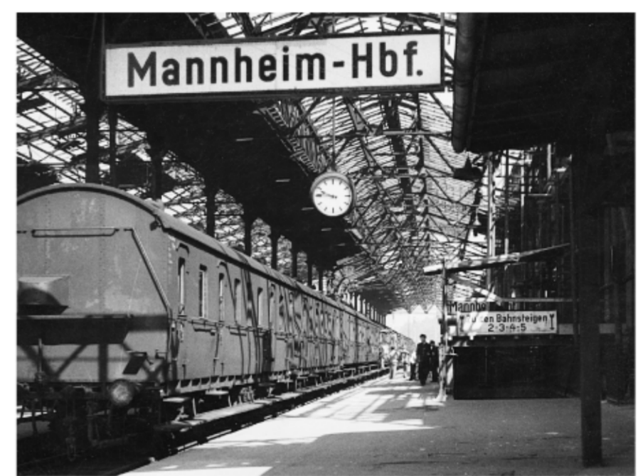
Im 2. Weltkrieg wird der Mannheimer Hauptbahnhof durch Bombenangriffe weitgehend zerstört. Noch 1949 ist die Überdachung der Bahnleise nicht wieder hergestellt.
