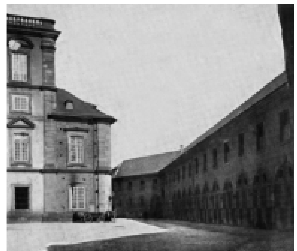
Die Schlossremise vor dem Abbruch. Im nördlichen Teil befindet sich ein Stall mit 21 Ständen.
