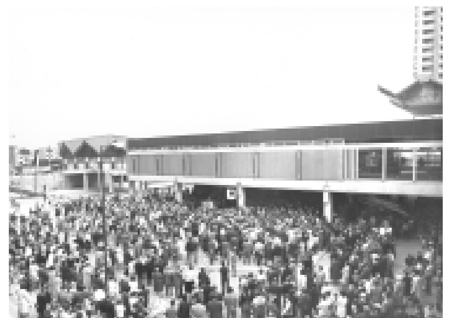
Das Stadtteilzentrum, ein langgestreckter, flacher Komplex mit Ladenpassagen, Büros, Arztpraxen und Wohnungen, umgeben von drei 23-geschossigen Wohntürmen, wurde von Architekt Helmut Striffler entworfen und unter reger Beteiligung der Stadtteilbewohner am 16. September 1969 eingeweiht.
