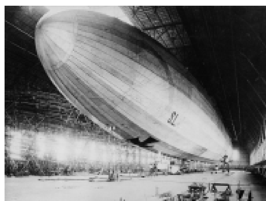
Montage eines Luftschiffs in der Halle in Rheinau. Das erste dort fertig gestellte stromlinienförmige Luftschiff mit Holzgerippe steigt als SL I am 17. Oktober 1911 in die Lüfte.
