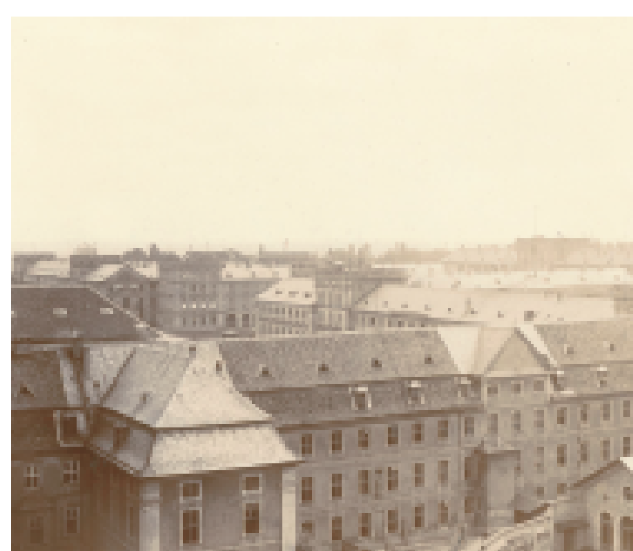
Blick auf die Rückseite des Alten Gymnasiums, um 1890. Das Gebäude verbindet die Jesuitenkirche mit dem Westflügel des Schlosses.
