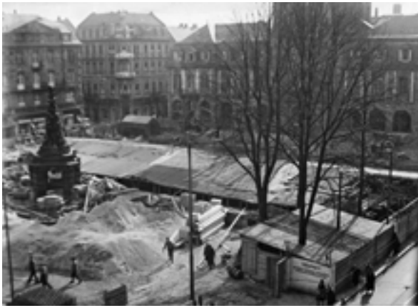
← Der Tiefbunker unter dem Paradeplatz wurde in den Jahren 1940 bis 1942 errichtet. Hier ein Foto aus der Bauzeit.
