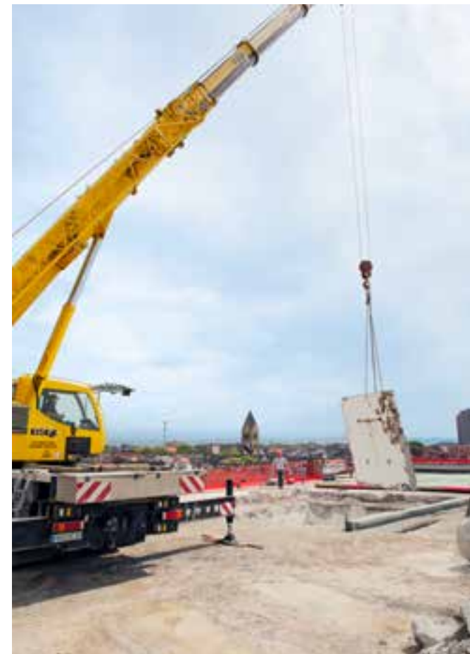
Abbrucharbeiten auf dem Bunkerdach.
