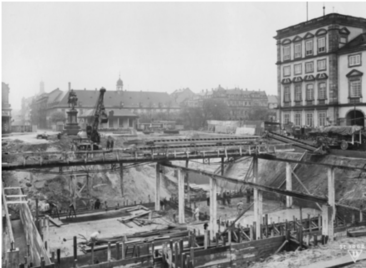
↑ Unter dem Ehrenhof des Schlosses befanden sich Schutzräume für 900 bis 3.000 Personen. Foto aus der Bauzeit, 1941.
