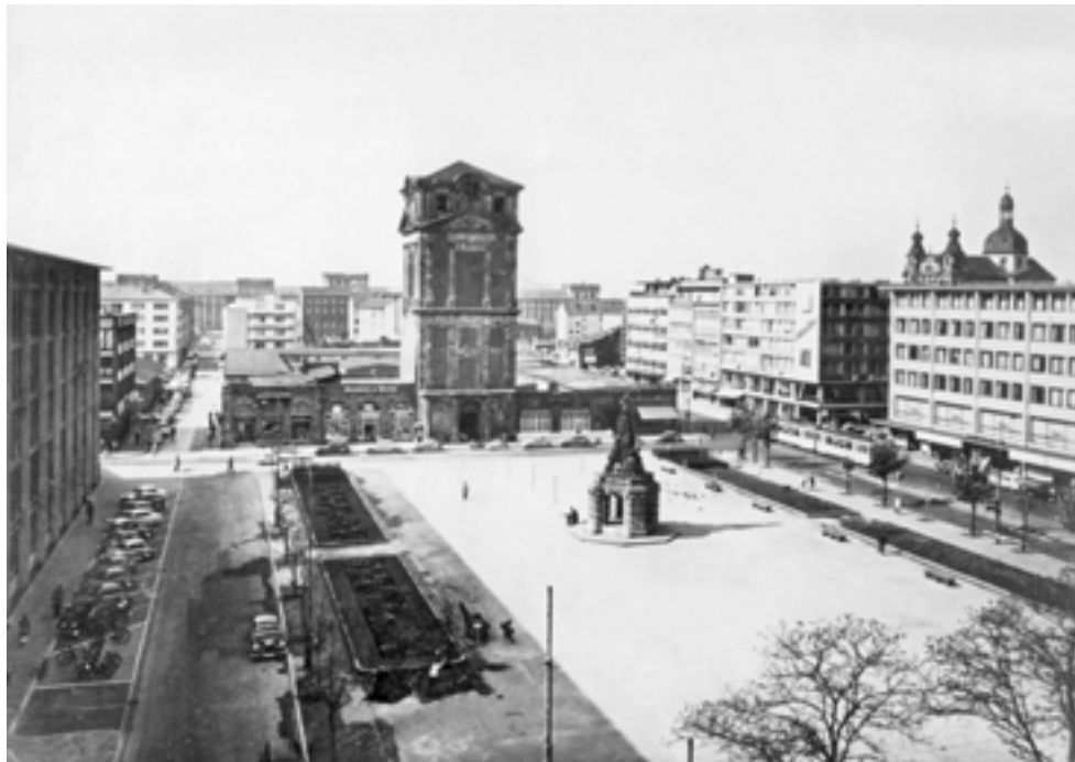
↑ Der Paradeplatz 1957 mit dem Grupello-Denkmal und dem später abgerissenen Turm des Alten Kaufhauses. Das Bunkerhotel unter der Südseite des Platzes besaß 29 Einzel- und 15 Doppelzimmer, es gab eine Hotelbar, ein Restaurant, ein Gemeinschaftsbad sowie ab 1948 auch einen Friseursalon. In manchen Monaten übernachteten über 1.000 Personen unter dem Paradeplatz, so dass die Stadt sogar eine oberirdische Erweiterung ins Auge fasste. Dazu kam es aber nicht mehr. Das Bunkerhotel wurde Ende der 1950er-Jahre geschlossen.
