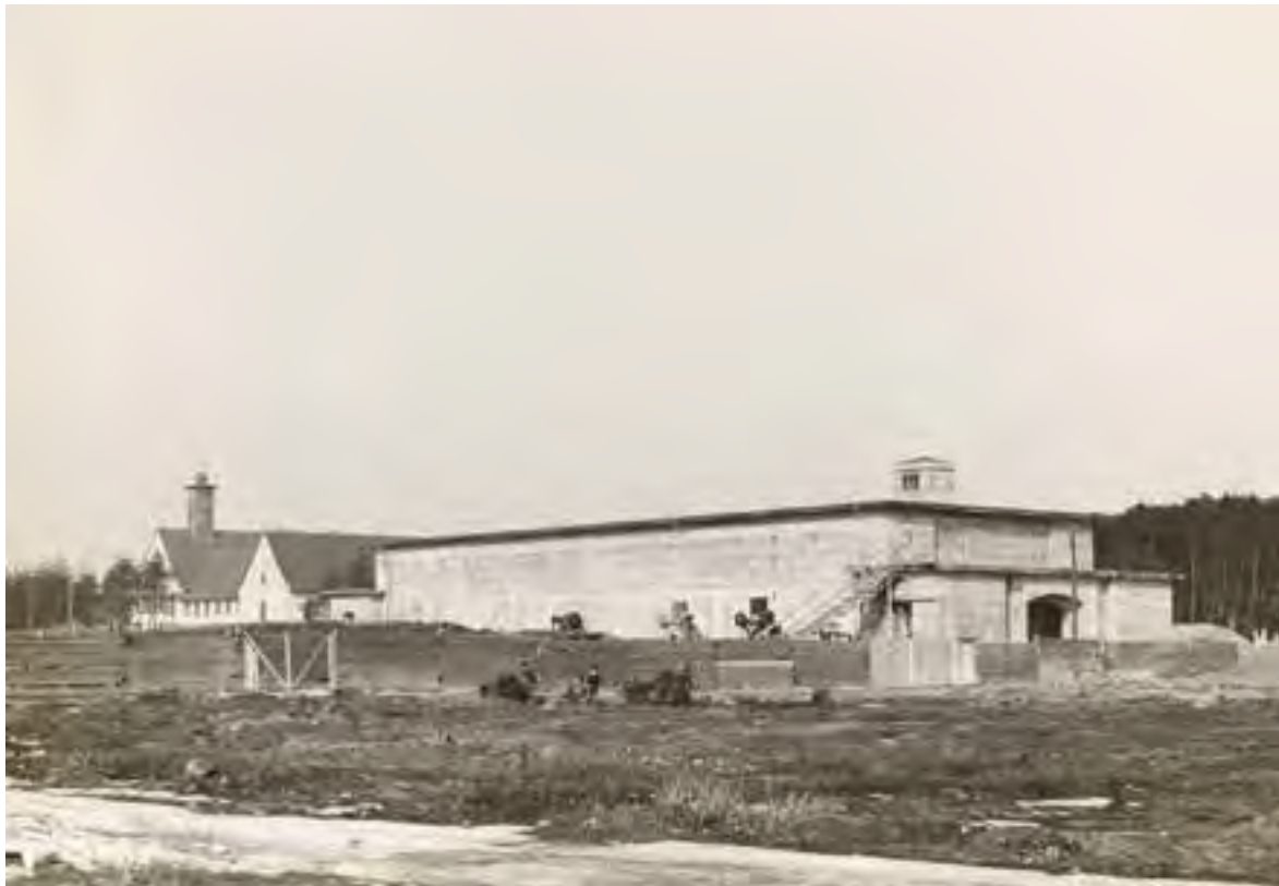
↑ Dieses Foto zeigt den Schönau-Bunker wie er 1941 realisiert wurde. Damals gingen die Nationalsozialisten noch vom „Endsieg“ aus. Dann aber kam es ganz anders und die Pläne für HJ-Heime und andere Repräsentationsbauten des „Dritten Reichs“ verschwanden in den Schubladen.
