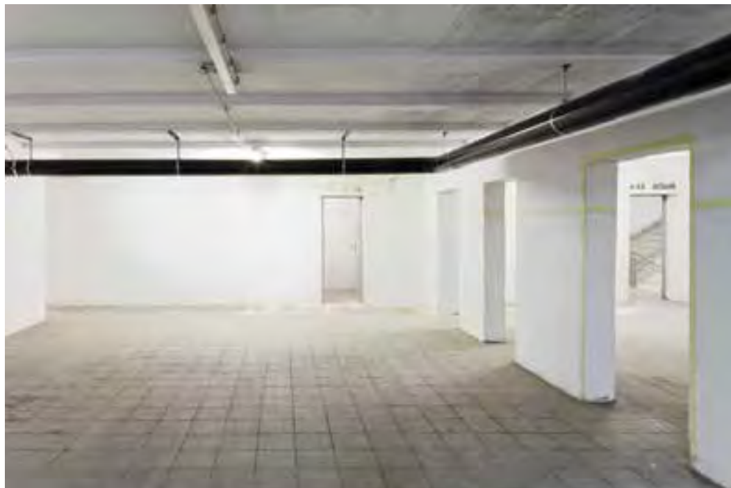
Raum im 4. Obergeschoss vor dem Umbau.
