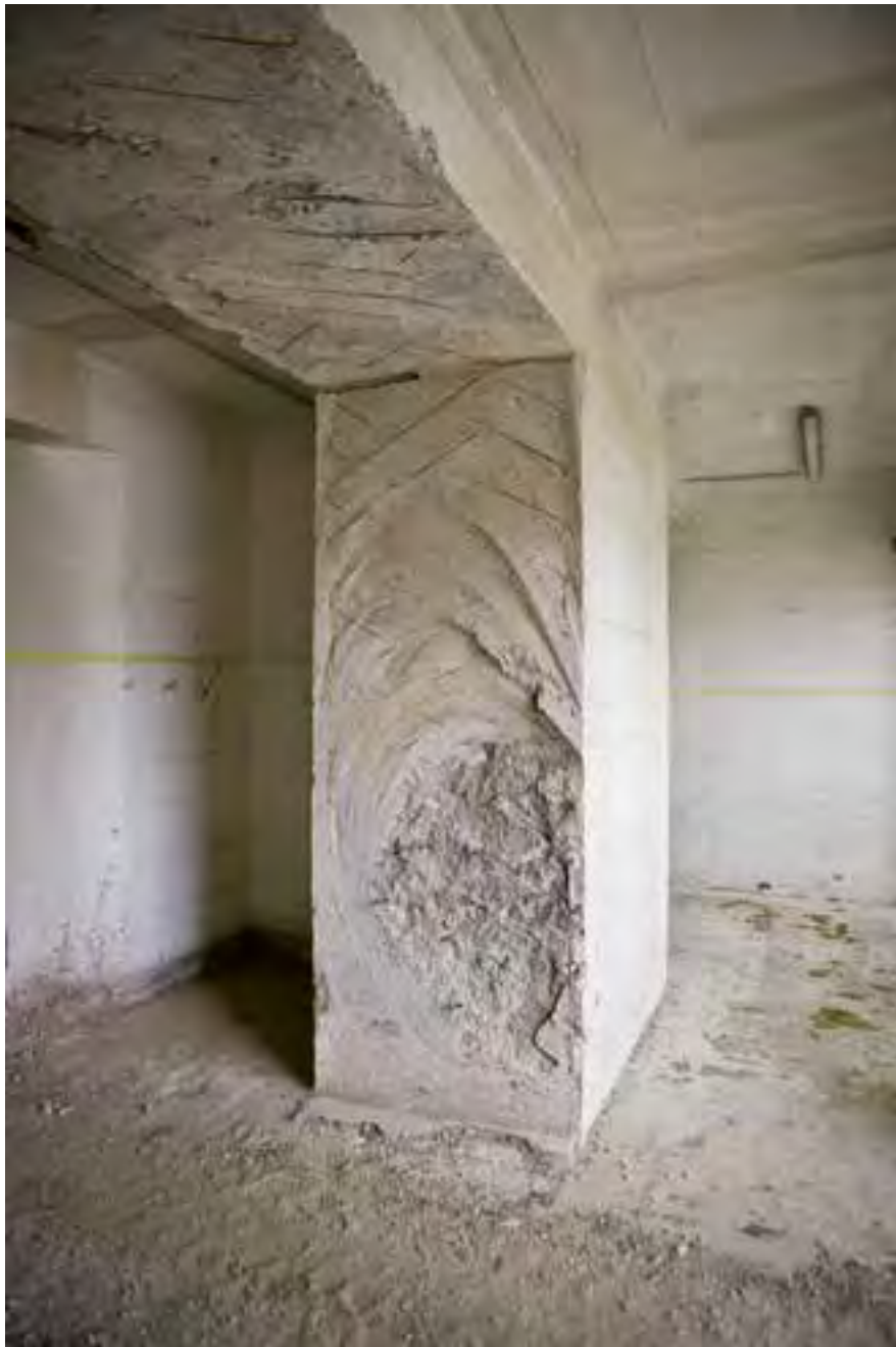
Wanddurchbruch im Eingangsbereich des Erdgeschosses.
