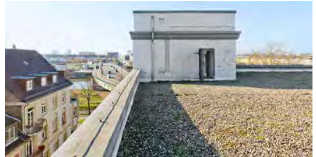
Das Bunkerdach vor dem Umbau.
