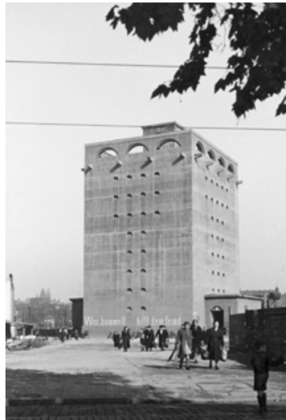
↑ Der turmförmige Bunker am Luisenring besaß 269 Liege- und 1.188 Sitzplätze, im Alarmfall konnte er bis zu 5.500 Personen aufnehmen. Auffallende architektonische Details sind die Rundbögen des Attikageschosses und die Wasserspeier, letztere wirken als Reminiszenz an mittelalterliche Wehrtürme. Heute beherbergt das Gebäude das Rechenzentrum der Stadt Mannheim. Foto von 1944.
