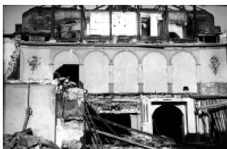
Beim Abriss des Theaters im September 1935 erinnern nur noch wenige Ornamente an den ehemaligen Glanz.
